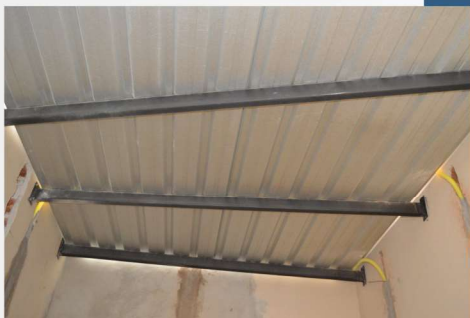
DOAÇÃO DE TELHAS PARA A COBERTURA DO CONFORTO MÉDICO DE PEDIATRIA
