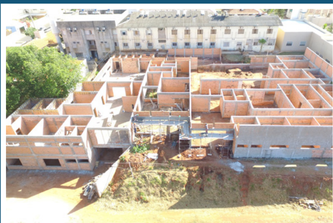
EVOLUÇÃO DAS OBRAS DA ONCOLOGIA
