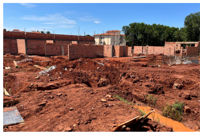
INÍCIO DA ALVENARIA DO CENTRO AVANÇADO DE ONCOLOGIA
