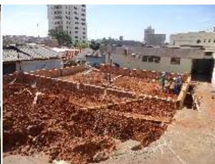
Construção da Hemodinâmica
